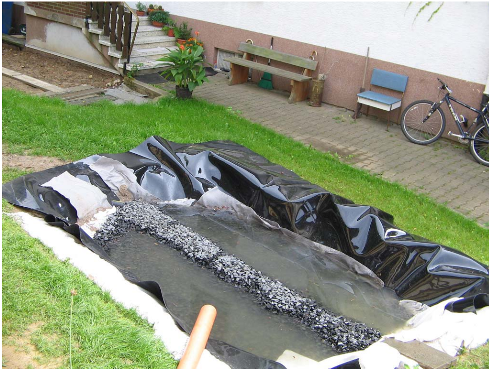
Abb. 6: PEHD-Dichtungsfolie und mit Basaltsplitt überdecktes Drainrohr
