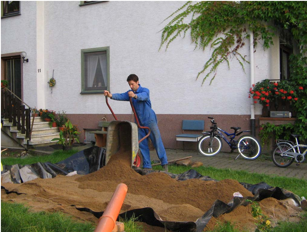
Abb. 7: Als Bodenfiltersubstrat wird Gewaschener Sand 0/4 eingebaut
