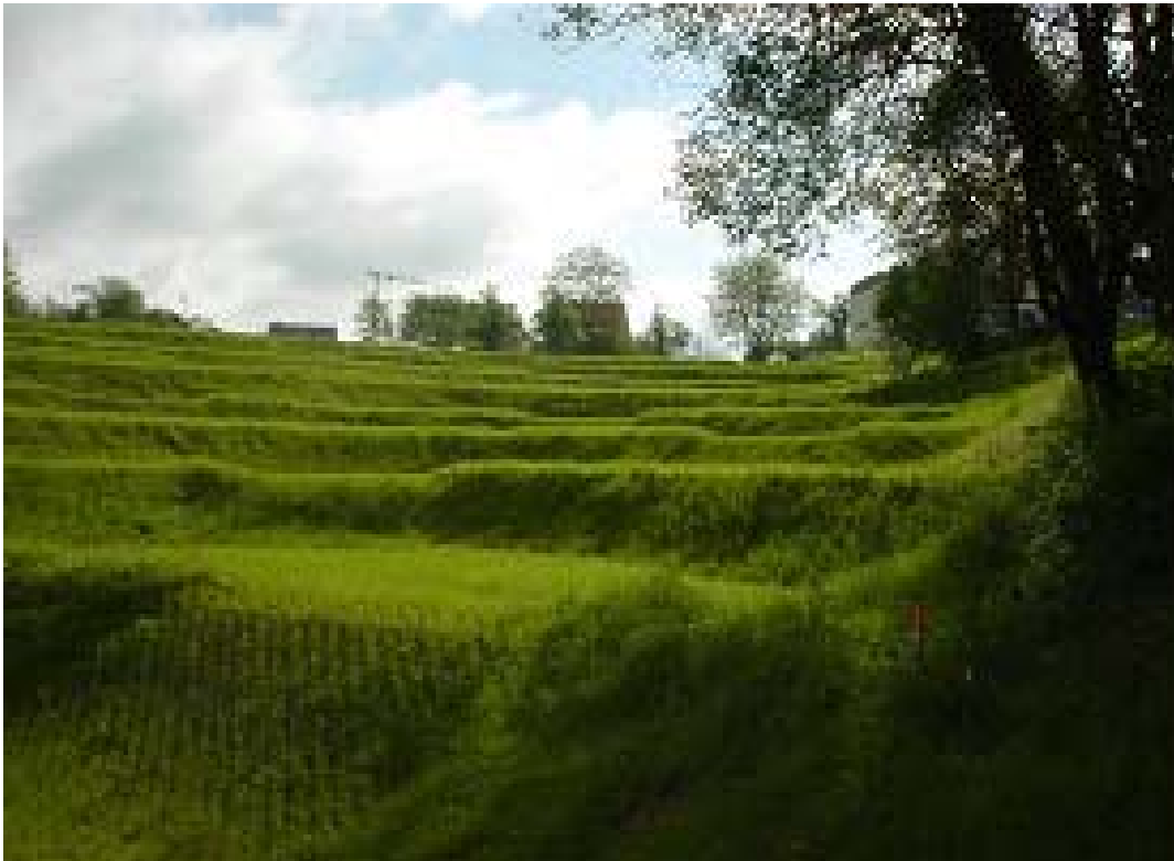
Abb. 12: Versickerungskaskaden Vallendar
