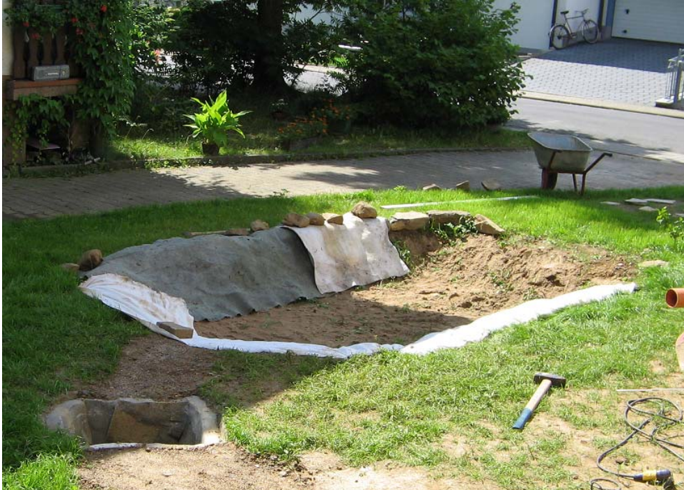
Abb. 5: Nach dem Aushub, auskleiden der Mulde mit Sand und Schutzvlies
