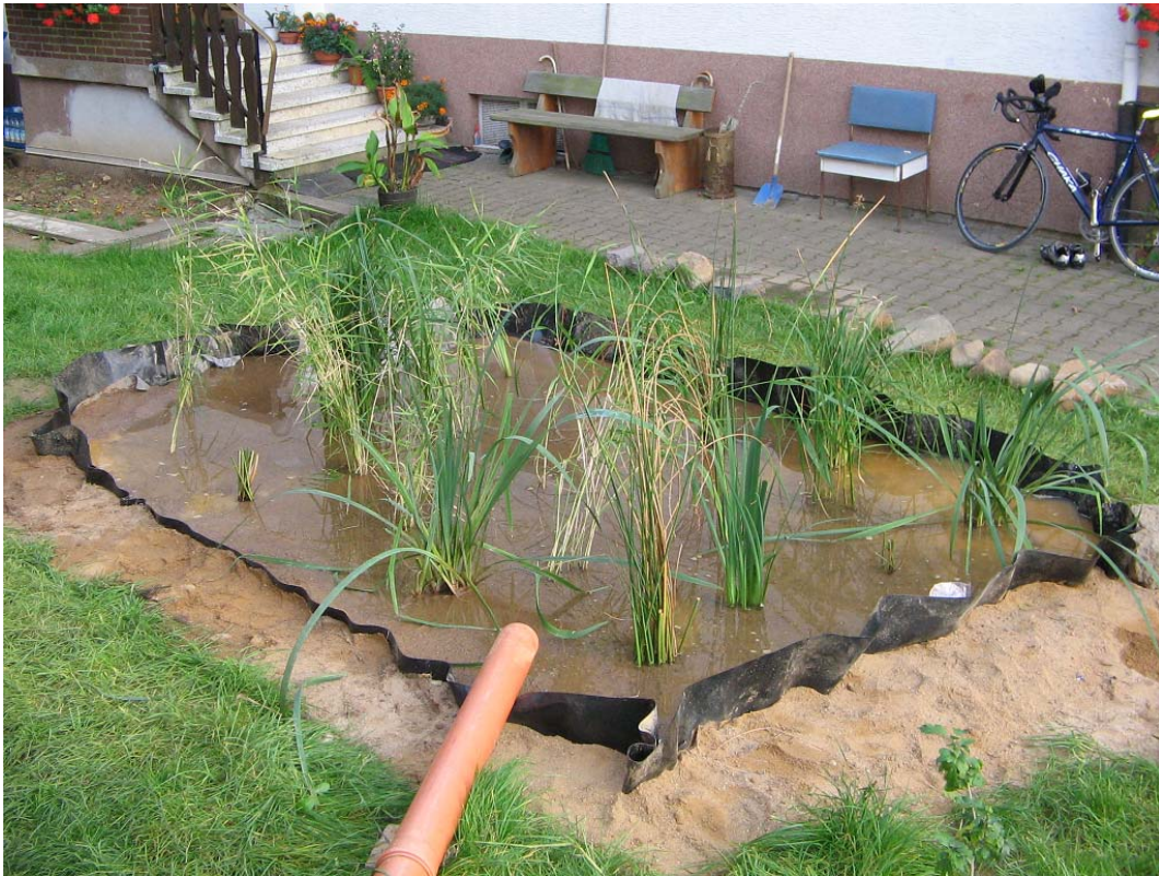
Abb. 9: Nach Bepflanzen mit amphibischen Helophyten wird die Pflanzenkläranlage geflutet.
