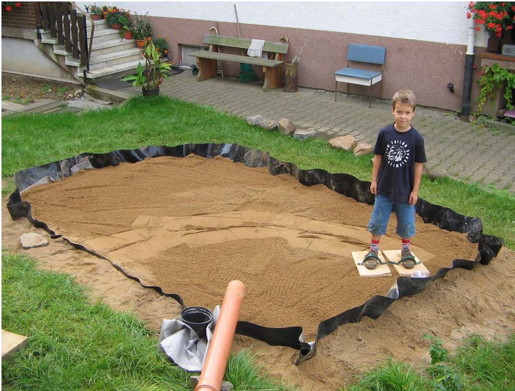
Abb. 8: Ein leichtes Verdichten nach den Substrateinabu verhindert spätere Absackung
