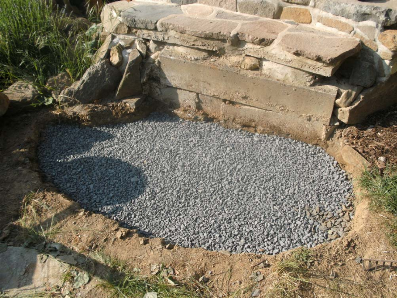
Abb. 3: Auffüllen mit Basaltsplitt
