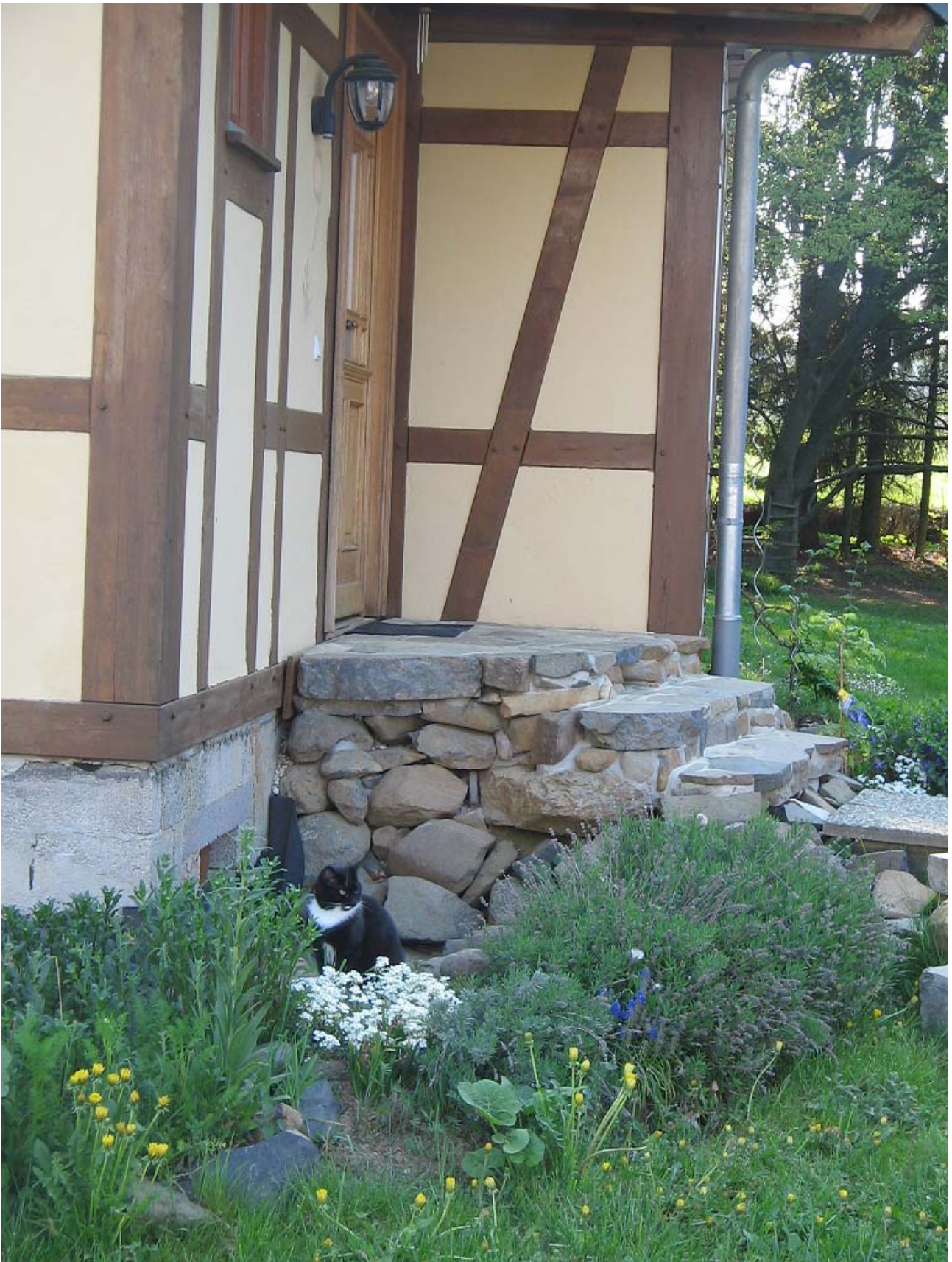
Abb. 1: Vom Kellerfundament bis hinauf zur Eingangstür ist das Podest Basaltsteinen, herbeigetragen aus den umliegenden Feldern, aufgebaut. Die ersten beiden Stufen sind fertig.
