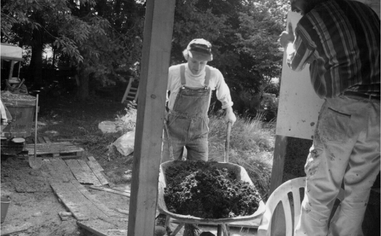
Bild oben: Der Hanflehm wird im Zwangsmischer gemischt und kann dann in die Schalung gestampft werden.
