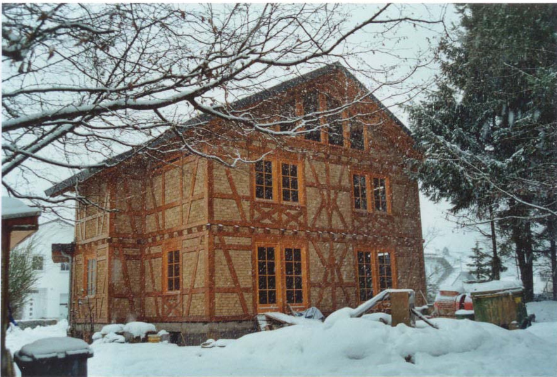
Bild oben: Mindestens 1 Jahr sollte ein neuer Fachwerk-Lehmbau „unverputzt“ bleiben. Das Haus muss einmal alle Jahreszeiten mit deren Innen- und Außentemperaturen „durchlebt“ haben.
