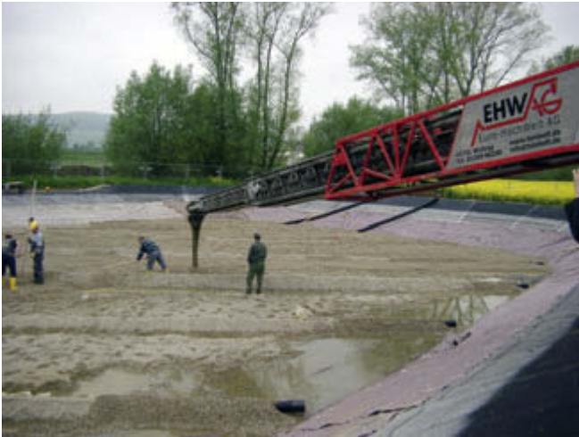
Abb. 3: Verdichtungsfreier Einbau des Retentionsbodenfilters mittels Telebelt
