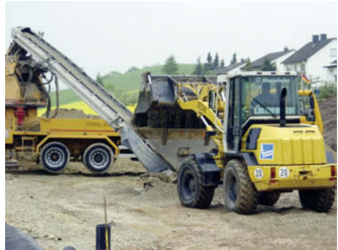
Abb. 2: Beschicken des Telebelt mit dem einzubauenden Retentionsbodenfilter
