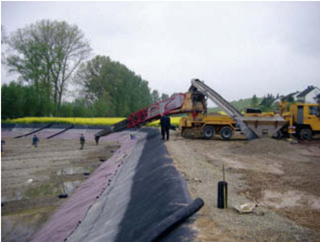
Abb. 1: Einbau des Retentionsbodenfilters in das Becken in Kasel-Calden
