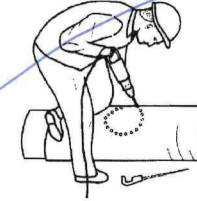
Einfache Materialbearbeitung auf der Baustelle bei FZ-Rohren
